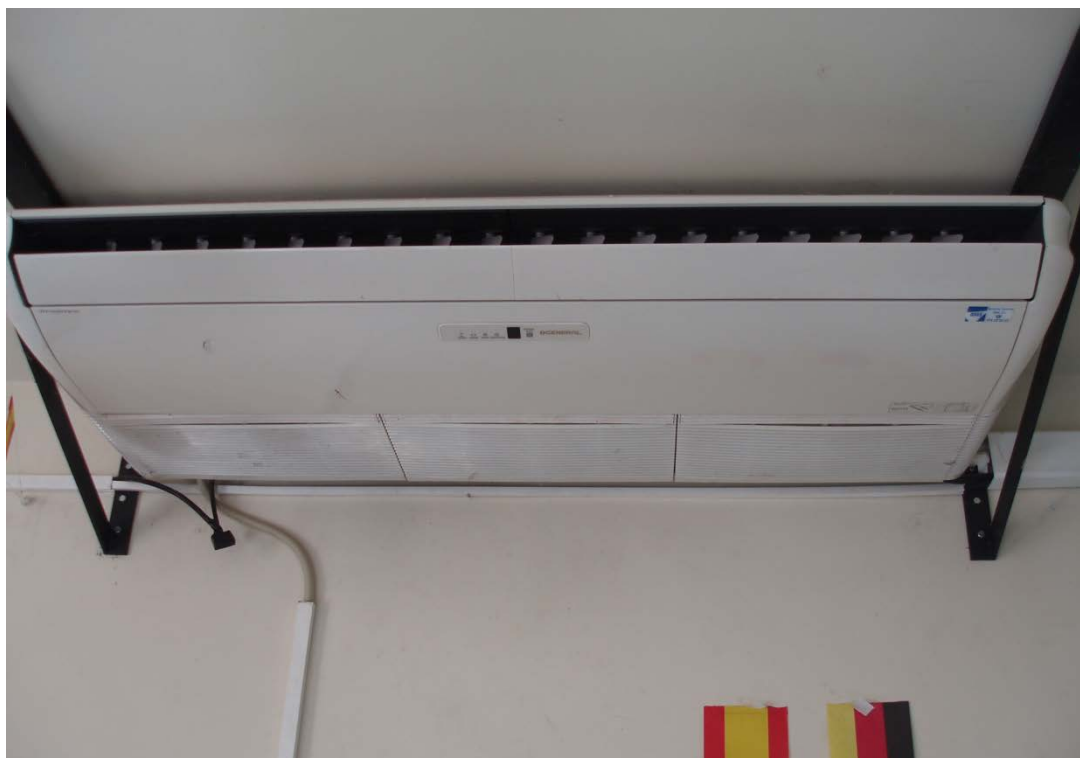
Ilustración 45: Split bomba de calor
