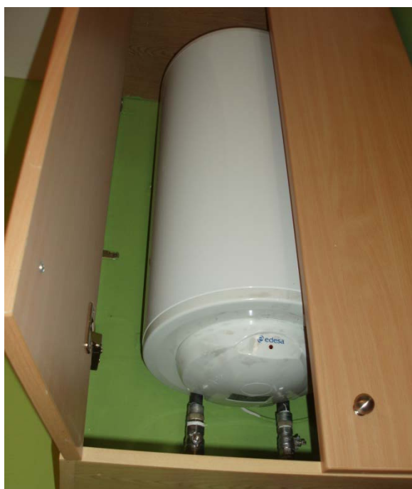
Ilustración 51: Termo eléctrico
