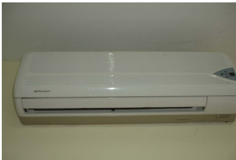
Ilustración 24: Split bomba de calor
