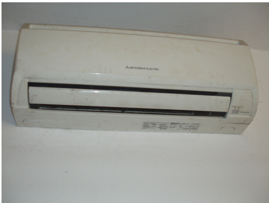
Ilustración 28: Unidad interior bomba de calor
