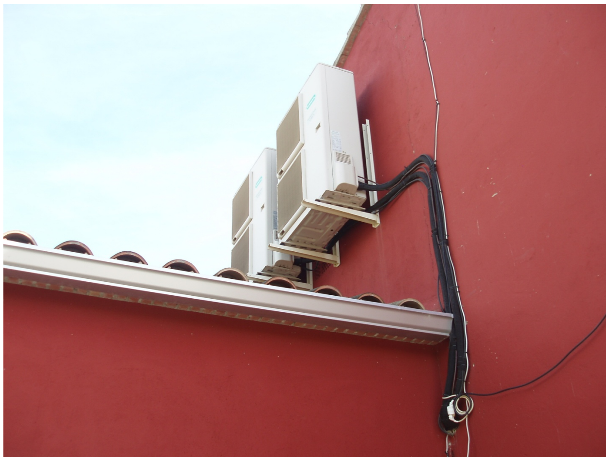
Ilustración 43: Unidades exteriores bomba de calor
