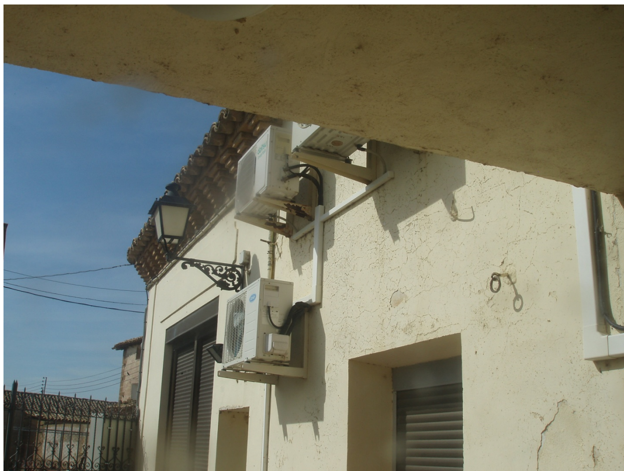
Ilustración 49: Unidades exteriores bomba de calor
