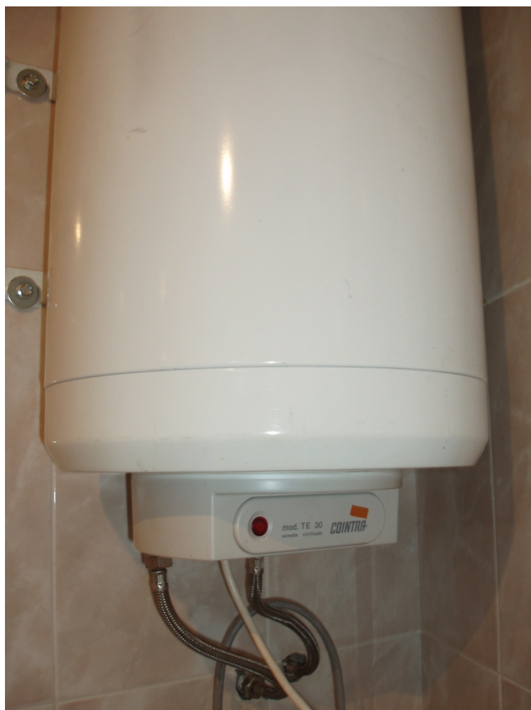
Ilustración 19: Termo eléctrico ACS
