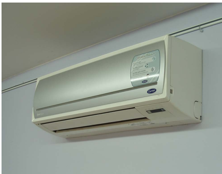
Ilustración 37: Split bomba de calor
