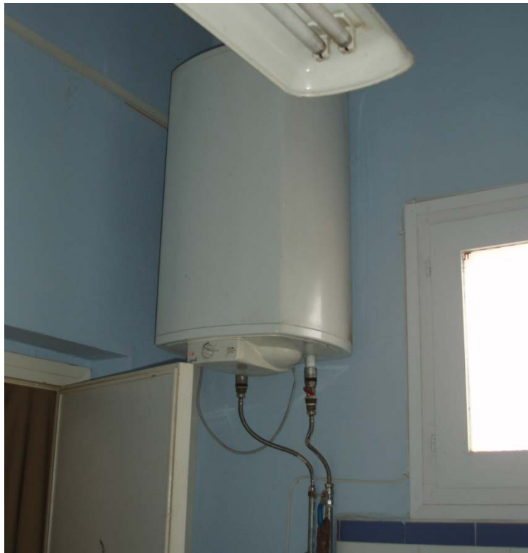
Ilustración 3: Termo eléctrico ACS
